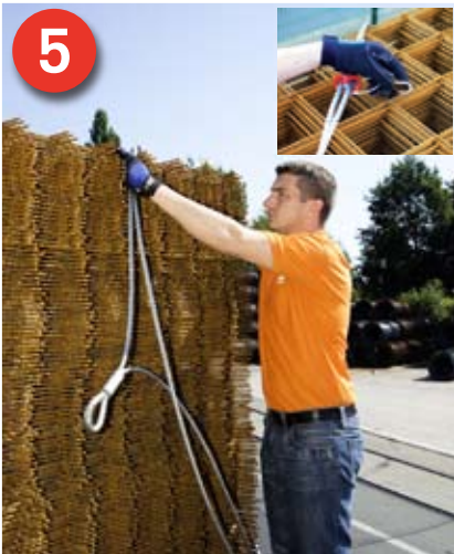
5 Fehlen Steckungen, kann z. B. das DoUniFlex-System verwendet werden. Der Haken (kleines Bild) verhindert das Abrutschen des Seils.
